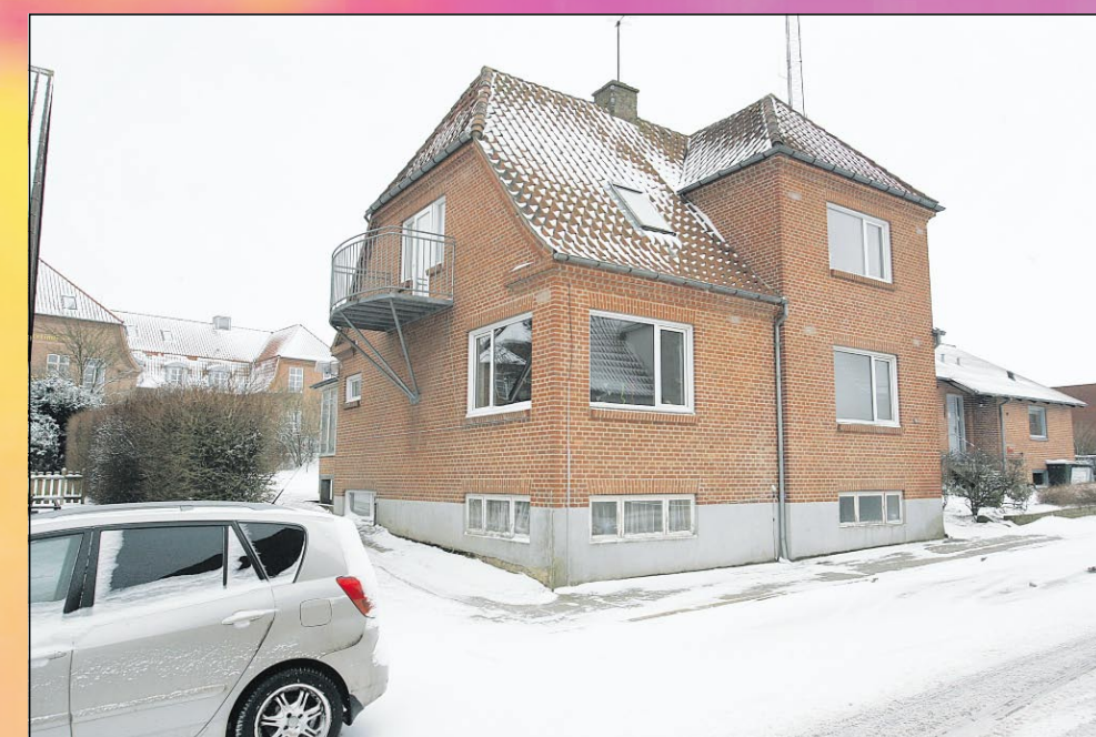
Det ser ud som om, der er lys i huset her i Kompagnigade i Skive. Det er der ikke. Varmetab giver de lyse partier.
